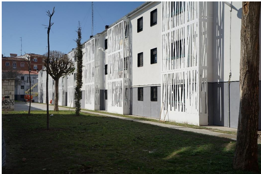
Figura 3.6. Bloques rehabilitados en el polígono 29 de Octubre de Valladolid.
