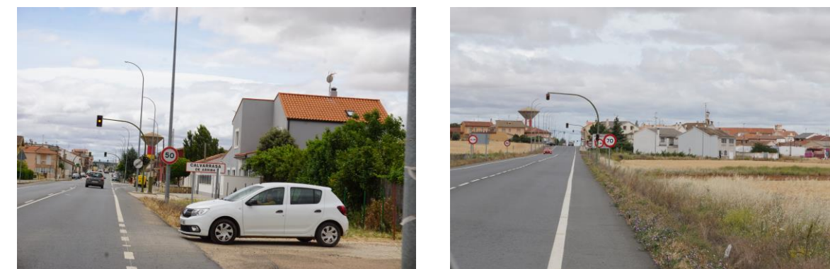
Semáforos de limitación de velocidad en los extremos norte y sur de la travesía
