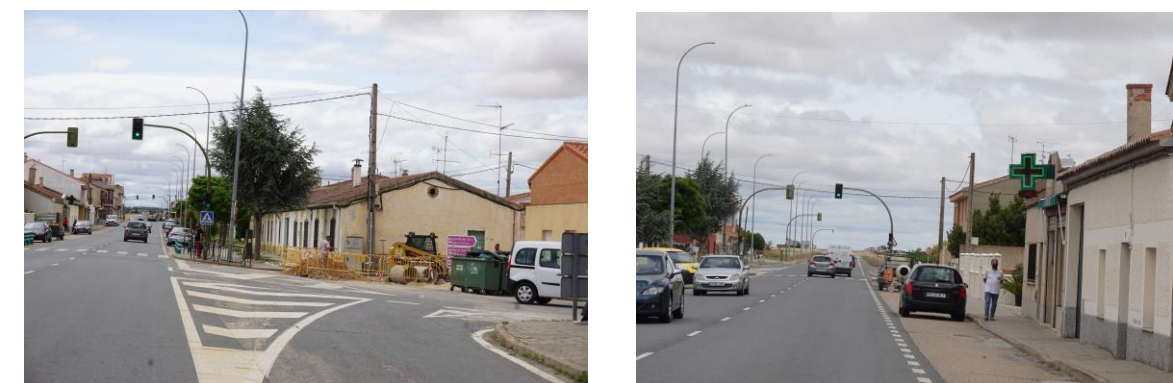
Semáforos en el nudo urbano con las calles Molino y del Baño y con la Avenida de la Peña
